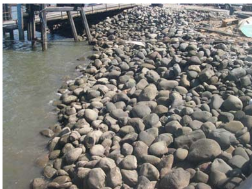
Figura Nº 41. Material de protección del talud.
