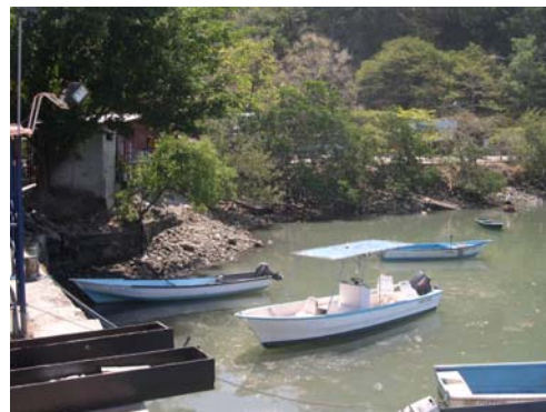
Figura N° 19. Erosión al Oeste del relleno
