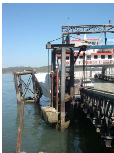
Figura Nº 2. Duques de alba, costado Oeste de la rampa
