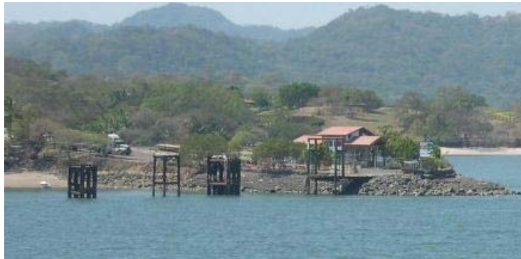
Figura Nº 20. Terminal de Ferries de Playa Naranjo
