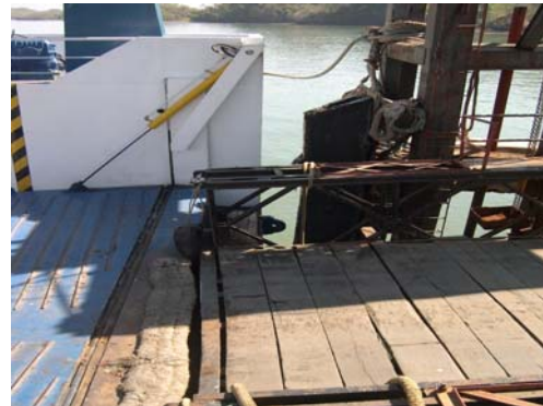
Figura N° 10. Contacto directo embarcación-rampa
