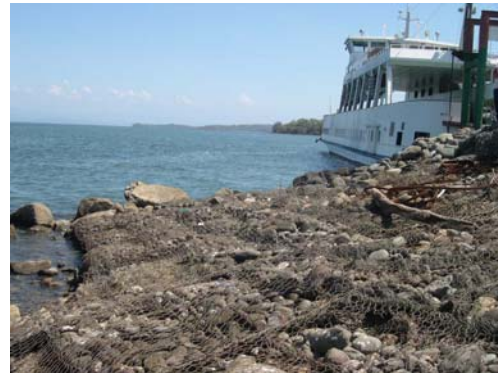
Figura Nº 33. Colocación de "colchonetas" de protección del relleno
