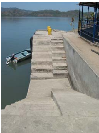
Figura Nº 11. Atracadero de "La Paquereña", a un costado de la Terminal de Paquera.
