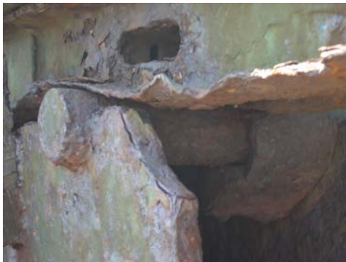
Figura N° 9. Apoyo colapsado.
