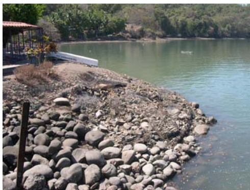
Figura Nº 12. Protección del relleno en el sector Norte-Oeste
