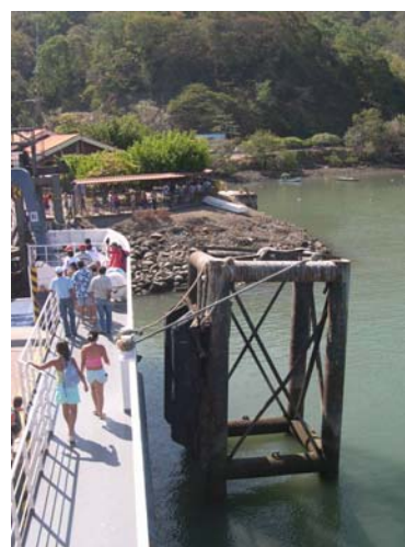
Figura Nº 3. Se observa operación de amarre. Vista desde el ferry
