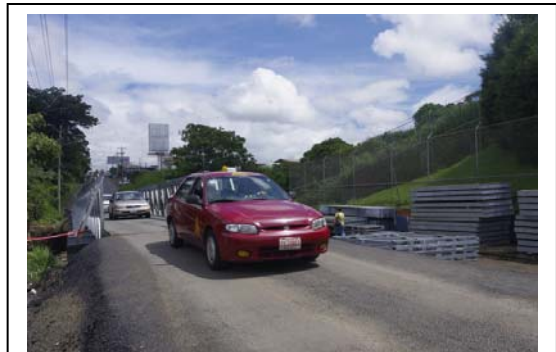
La colocación del segundo puente metálico en Tibás, quedará para el fin de semana.
