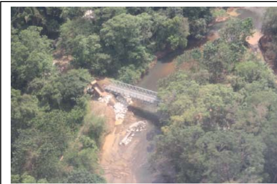
Para facilitar el paso a sectores como Sámara y Nosara se repuso el puente sobre el río Frío
