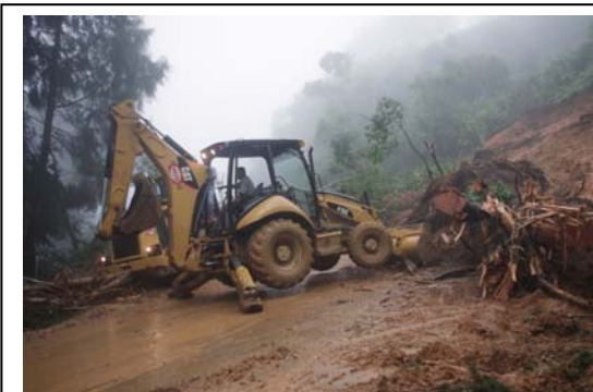
Ya se habilitó el paso por la ruta que permite llegar a la zona de Los Santos por San Ignacio de Acosta
