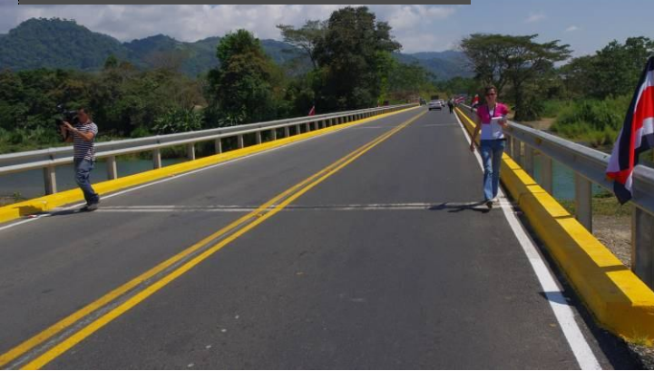
Puente sobre Rio Savegre
