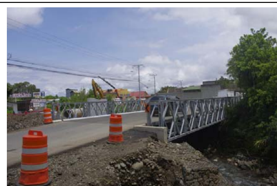
El puente temporal permite trabajar con mayor facilidad en la ampliación sobre el río Burío.
