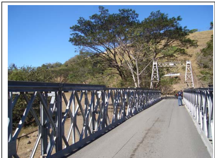
CONAVI verificó buen estado de puente avanzada la semana anterior.
