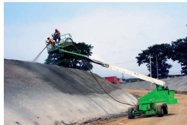
Este talud se recubrió de concreto a inyectado, para evitar filtraciones de agua.
