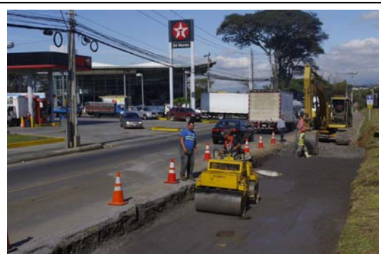
Ya se trabaja en la ampliación de la carretera en el cruce de la Texaco, en Lagunilla de Heredia.
