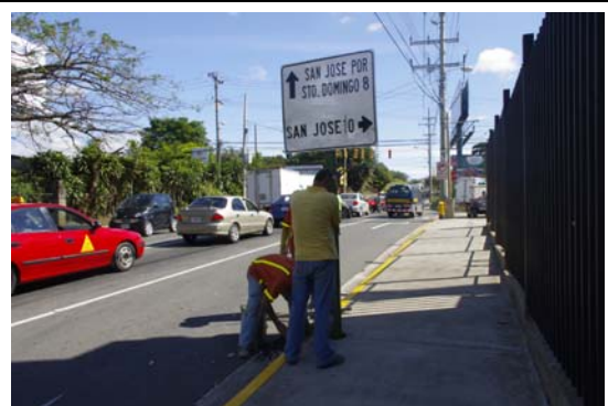
Ingeniería de Tránsito está colocando señales informativas para orientar a los conductores
