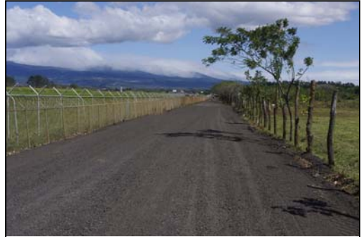
Obras Públicas mejoró el ancho y la condición de ruedo de la calle La Candela.
