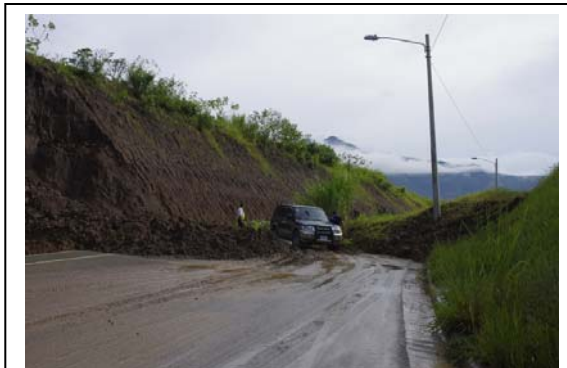
El tránsito por la zona es peligroso, dado lo resbaladiza que está la carretera, producto del barro arcilloso.
