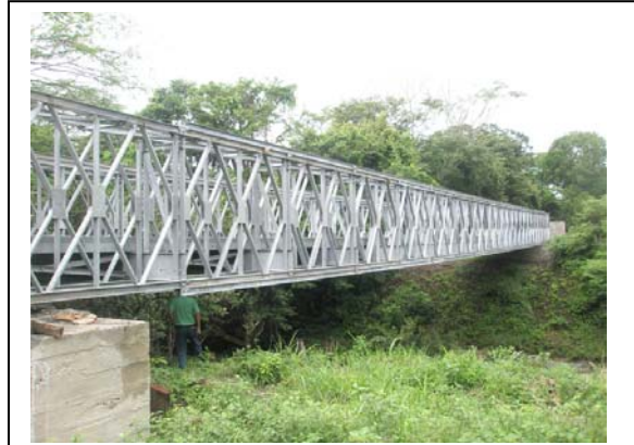
El puente sobre el río Potrero ya está en servicio. En él el MOPT invirtió ¢173 millones
